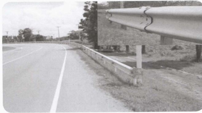
รูปที่ ๔ การติดตั้งราวกันอันตรายแบบราวเหล็กลูกฟูกบนเสาอ่อนข้างทาง
