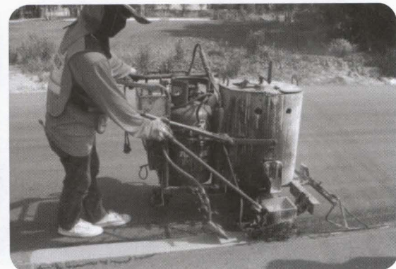
รูปที่ ๓๒ การทำ Primer ด้วยผลิตภัณฑ์ของผู้ผลิตสี ทำการทาสีด้วยเครื่อง ที่ควบคุมอุณหภูมิได้ รูปขณะดำเนินการตีเส้นจราจร
